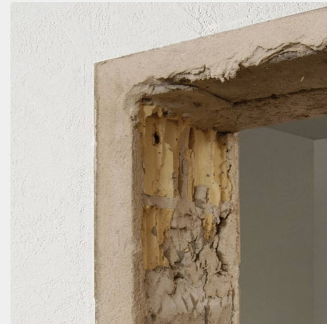
Die Wand nach dem Entfernen der alten Zarge.
