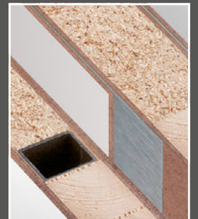
Klimaklasse III mit Stahlrohrverstärkung oder Aluminiumverbundabspernung
